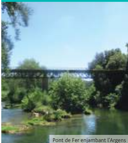
Pont de Fer enjambant l'Argens
